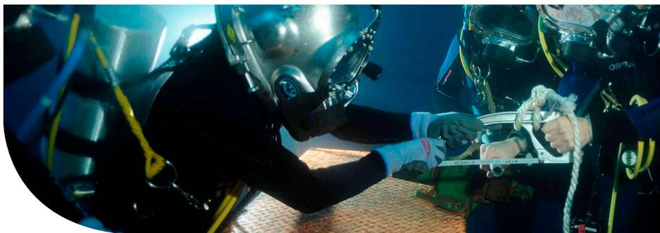
**Soldadura Submarina:** Unión de elementos estructurales mediante punto y cordón de soldadura, reforzamiento de uniones de elementos estructurales, ampliación de estructuras metálicas sumergidas, instalación de ánodos de protección catódica de estructuras sumergidas.
